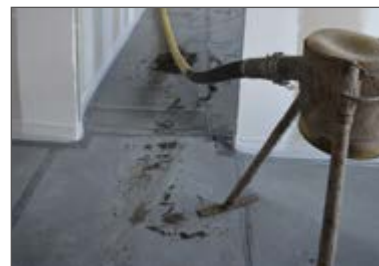
Versterkte chape gieten met een dikte van \pm 8 cm op de insulit Bi+20
