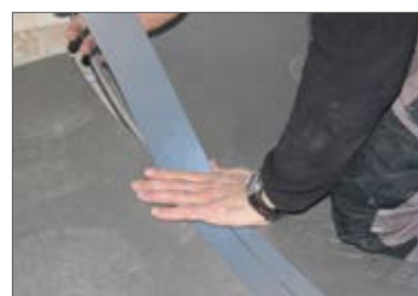
Thermisch afdichten met de meegeleverde StickelTape
